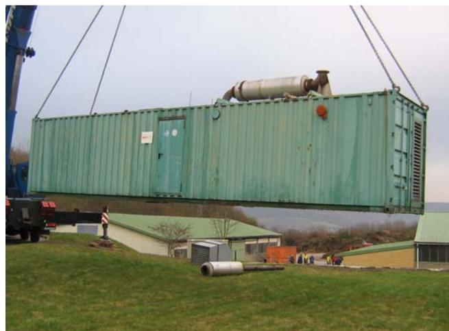
Demontage des Blockheizkraftwerkes auf der Abfallentsorgungsanlage Beverungen-Wehrden im November 2007
