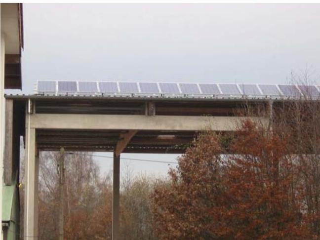
das öffentliche Stromnetz wird die von den Solarzellen erzeugte Gleichspannung von einem Wechselrichter in Wechselspannung umgewandelt.
