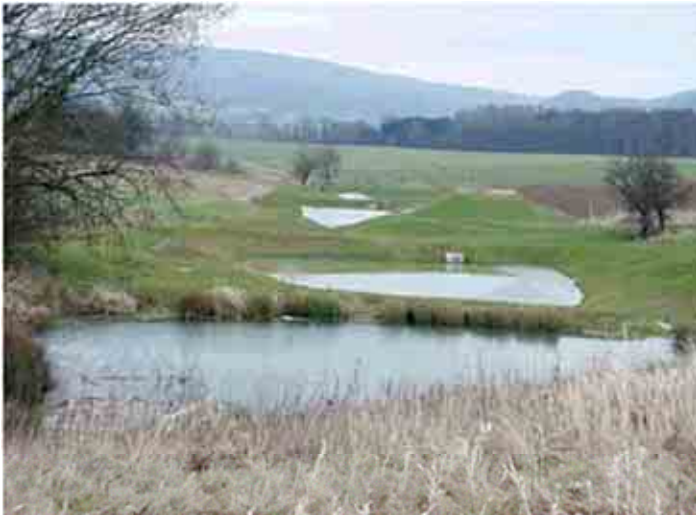
Abbildung 2.2: Teichbauwerke Deponie Steinheim
