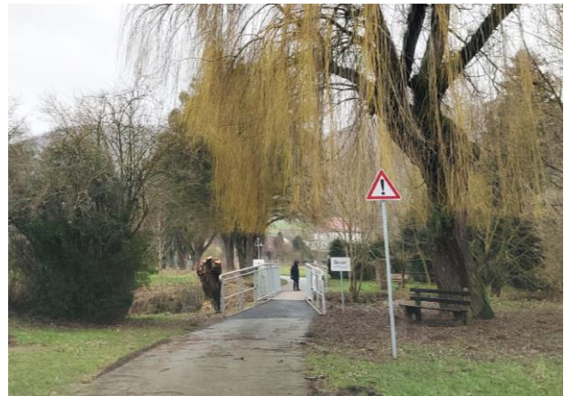
Mangelhafte Brückenbreite (vgl. Maßnahme W4) Beverungen
