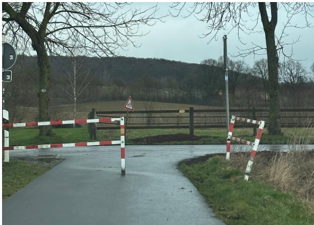
Umlaufsperrn (vgl. Maßnahme H14) Schäferhof Brakel
