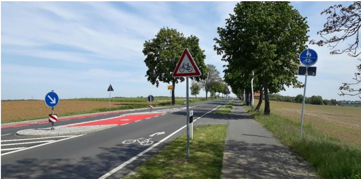
Abbildung 25 Markierung von Piktogrammen für Übergang Fahrbahnführung und Radverkehrsanlage (OWL GmbH 2021)
