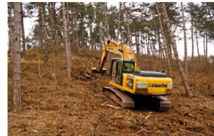
Abräumen von Kronenschnitt und Roden von Wurzelstubben mit dem Bagger
