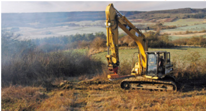
Maschinelles Entbuschen mit dem Bagger
